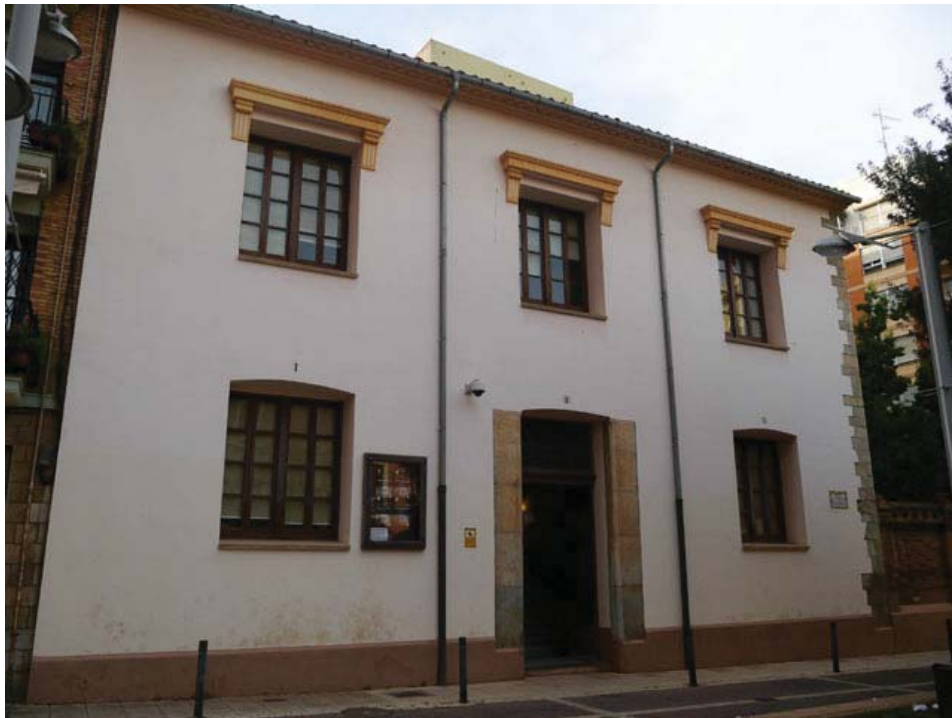
Centro Cultural Las Aulas
