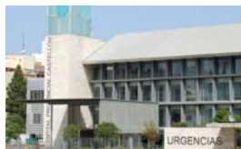
Nuevo Hospital Provincial 43
