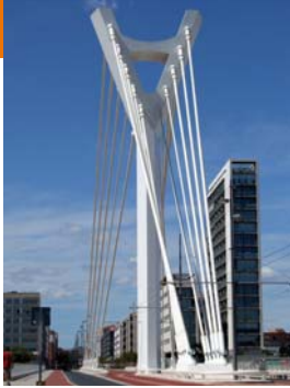
Puente de acceso a la UJI 11
