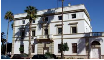
Antiguo edificio de Aduanas 2
